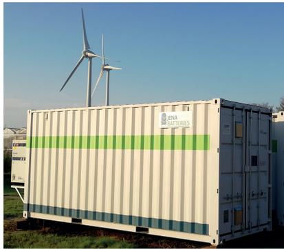
**In dem Container** im niederländischen Lelystad befindet sich eine metallfreie Redox-Flow-Batterie von JenaBatteries. Es ist ein in einem Smart Grid eingesetzter Prototyp. Er hat eine Speicherkapazität von 100 kWh. Gespeichert wird überschüssiger Sonnen- und Windstrom. *Bild: JenaBatteries*
